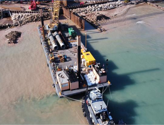
Tras muchos años de planificación, ha comenzado el proyecto Raw Water Improvements (RWI) de Sheboygan Water Utility. Este proyecto incluye la construcción de una nueva estación de bombeo de baja elevación y una estructura subterránea para reemplazar las obsoletas infraestructuras construidas en 1929 y 1887. Además, el proyecto incluye la instalación de una tubería de toma de agua de 6500 pies en el lago Michigan. Con esto, se reemplazará una obsoleta infraestructura construida en 1909 y 1959.
