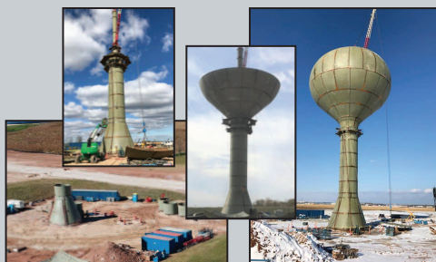
Construcción de la torre de agua de Horizon Drive en proceso.
